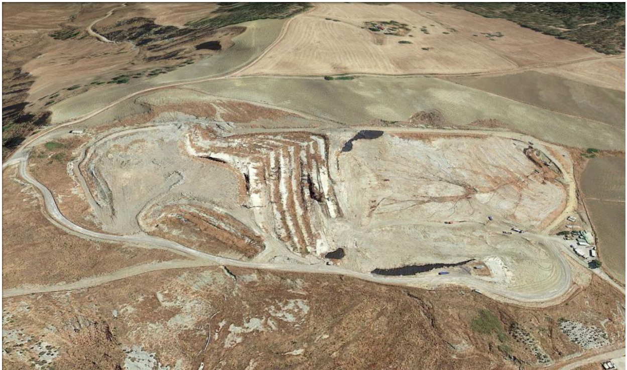
Figura 91 Vasca della discarica in esaurimento di cui è previsto l'ampliamento
