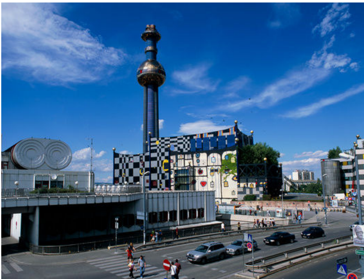
Figura 6 Termovalorizzatore di Vienna
