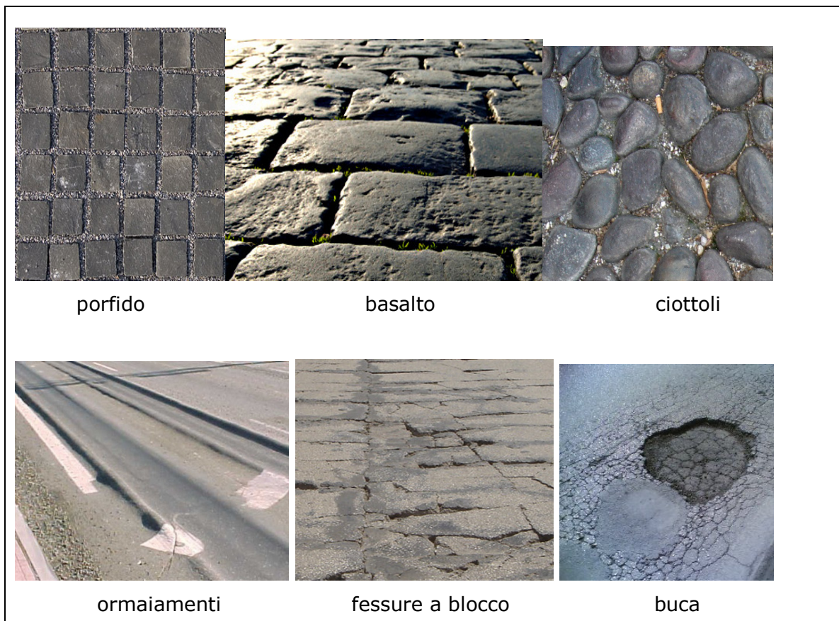
Figura 73 Tipologie di pavimentazioni e di ammaloramenti delle strade ennesi che riducono il livello di servizio di spazzamento
