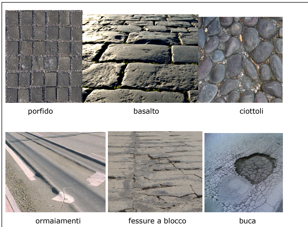
Figura 73 Tipologie di pavimentazioni e di ammaloramenti delle strade ennesi che riducono il livello di servizio di spazzamento
